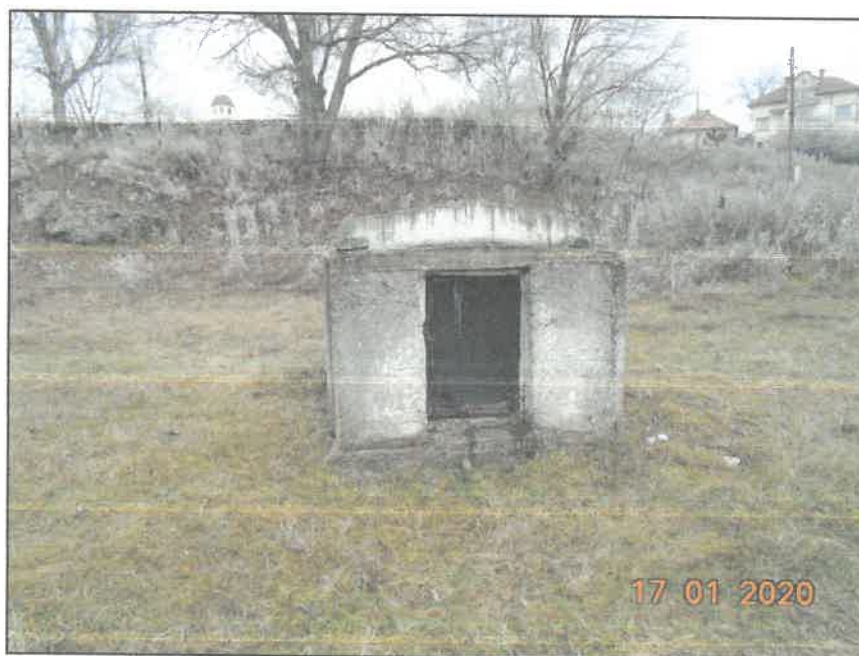
Сн.2. Външен изглед на СШ отблизо
