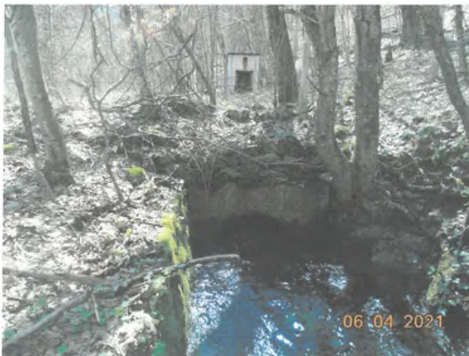
Сн.7. Изливен канал
